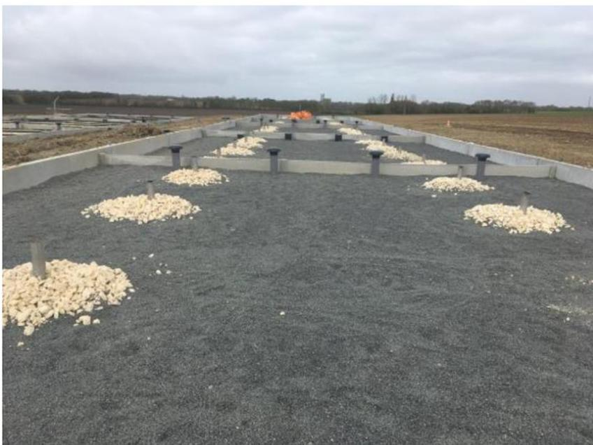
*Chantier de l'unité de traitement des eaux usées de Loire Les Marais – 1<sup>er</sup> étage avant plantation des roseaux*
