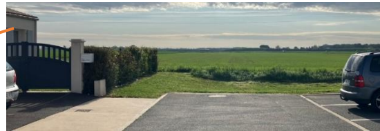
Amorce de voirie en partie Nord par la rue des Vignes (rue de l'Othello)
