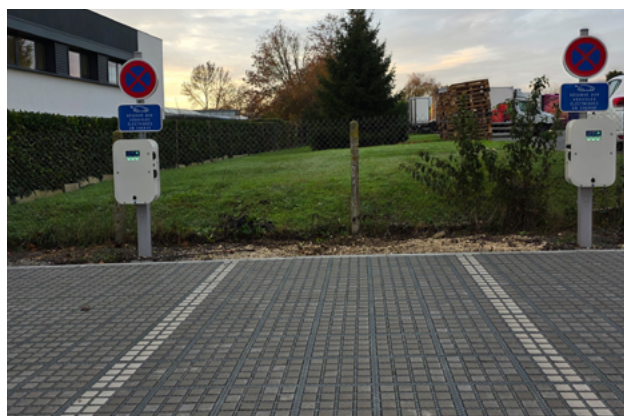
Nouveau parking végétalisé avec bornes électriques du siège Eau 17.
